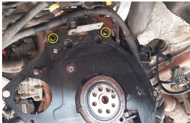
Image 1 : Les pions de centrage sur le bloc-moteur
